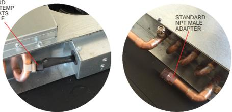
RIGHT SIDE CONTROL BOX WITH EASY CONNECT AQUASTAT. SUPPLY AND RETURN PIPING RUNS TO BACK Fig. 3
